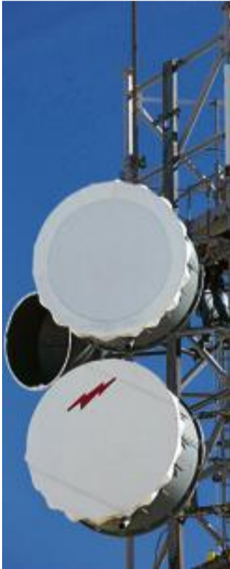
Circet est spécialisé dans l'installation de pylônes pour la téléphonie mobile. Photo DR
